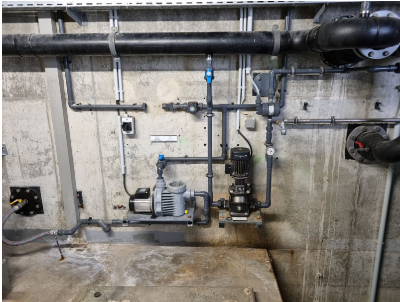
Abbildung – Blick zu Messwasser- und Chlorgasinjektorpumpe
